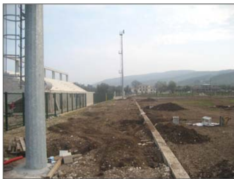
Lo stato dei lavori nella scorsa primavera
